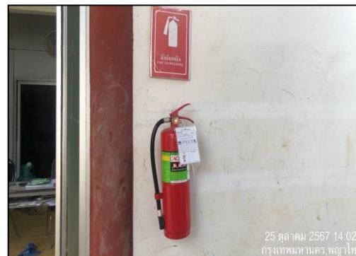
ภาพที่ 30 ถังดับเพลิงและการตรวจสอบถังดับเพลิง
